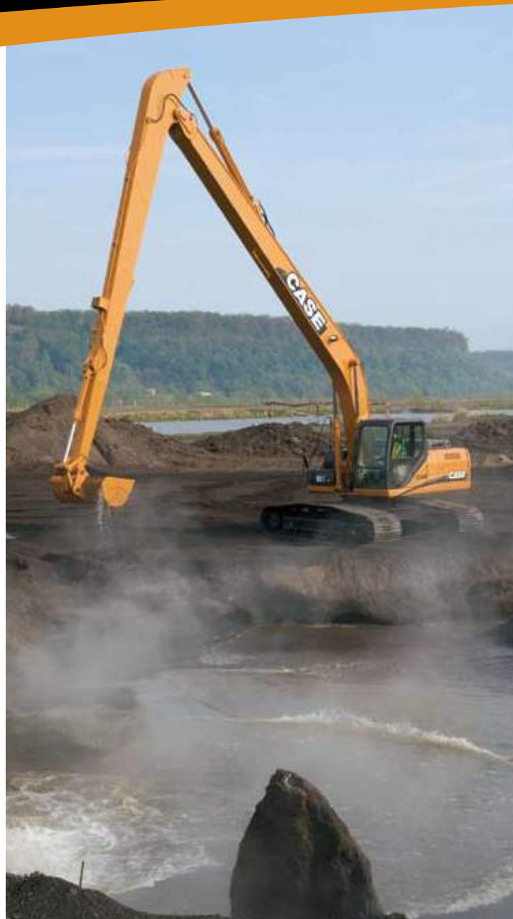
Excavación de Zanjas
